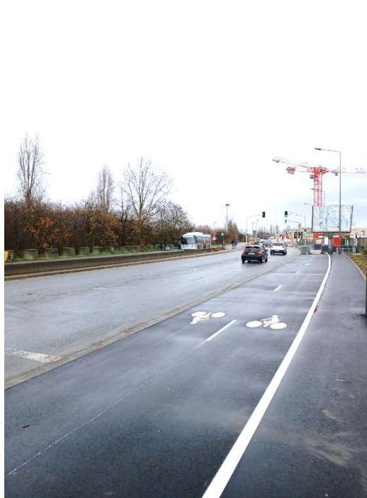
La RD136 après travaux - ©CD94
