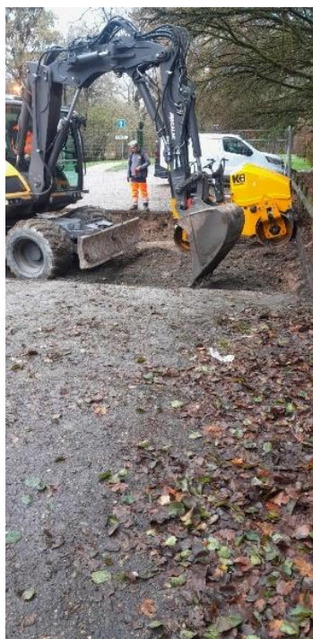
Avant travaux - ©CD94
