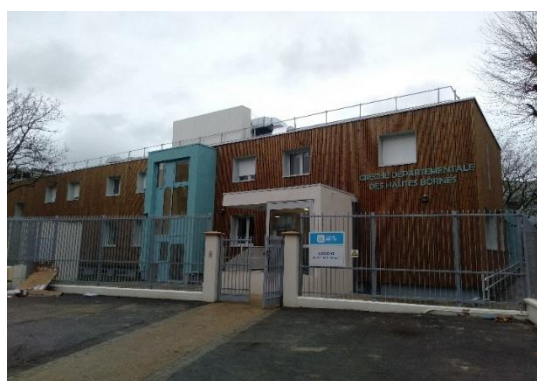
Crèche les Hautes Bornes à Orly après travaux - ©CD94
