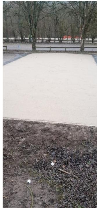
Après travaux - ©CD94
