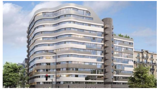
Projet de réhabilitation des 178 logements sociaux à Saint-Maurice : amélioration énergétique de E à C - ©CD94
