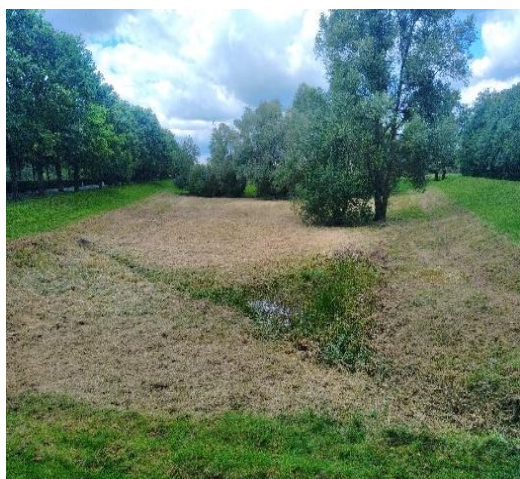
Bassin de rétention des Marmousets avant travaux - ©CD94
