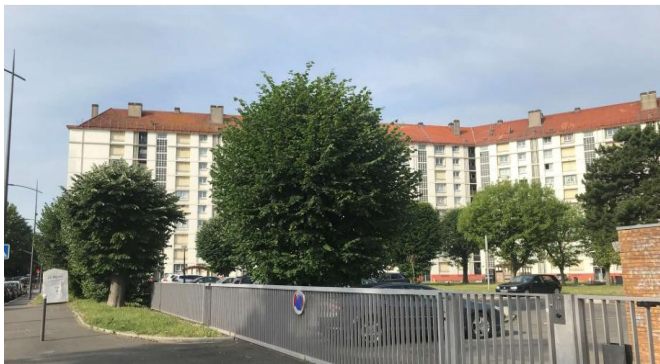
209 logements sociaux avant réhabilitation à Villeneuve-Saint-Georges - ©CD94
