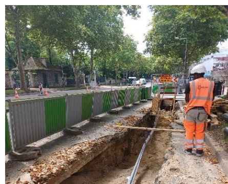
Travaux de redimensionnement du collecteur d'eaux usées à Créteil - ©CD94
