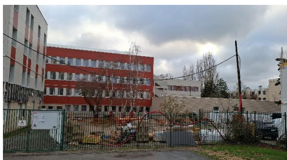
Travaux au collège Molière à Chennevières-sur-Marne - ©CD94
