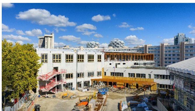
Collège Louis Issaurat à Créteil - Chantier en cours (octobre 2025) - ©CD94
