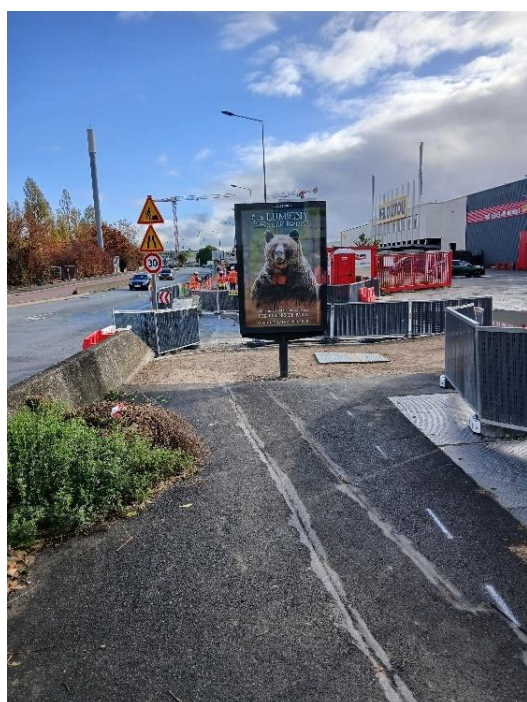
La RD136 avant travaux - ©CD94
