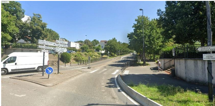
Le Giratoire du Colonel Grancey (RD145) avant travaux - ©CD94
