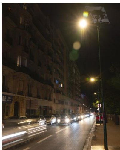
Ensembles solaires sur le quai de la République à Saint-Maurice ©L.Schoenhentz - CD94
