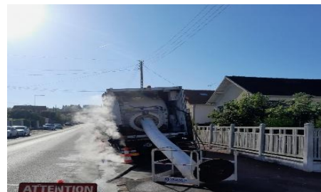
Travaux de réhabilitation du réseau d'eaux pluviales à Sucy-en-Brie - ©CD94
