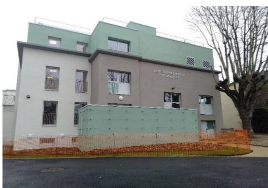
Crèche les Gondoles à Choisy-le-Roi après travaux - ©CD94
