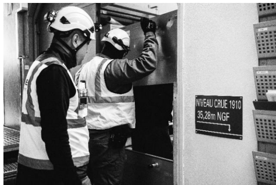
Pose des batardeaux pour la mise en sécurité du site de Rieffel à Maisons-Alfort dans le cadre de l'exercice HYDROS 25 - ©CD94
