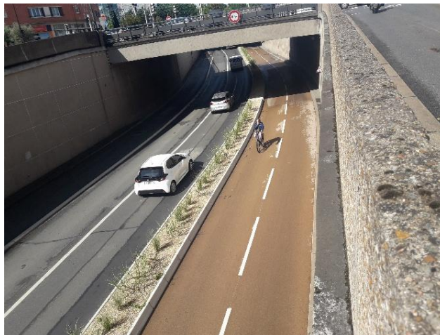
La RD4 après travaux - ©CD94
