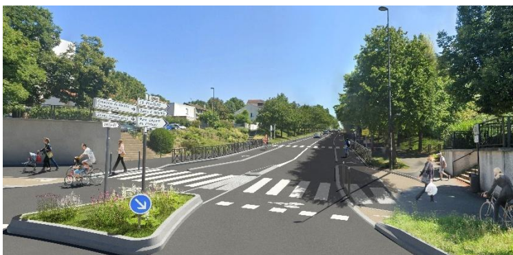
Le Giratoire du Colonel Grancey (RD145) après travaux - ©CD94
