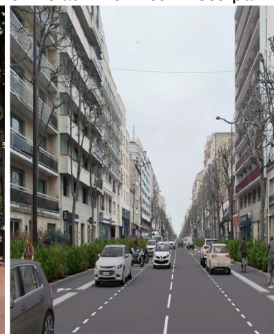
La RD6 après travaux - ©CD94
