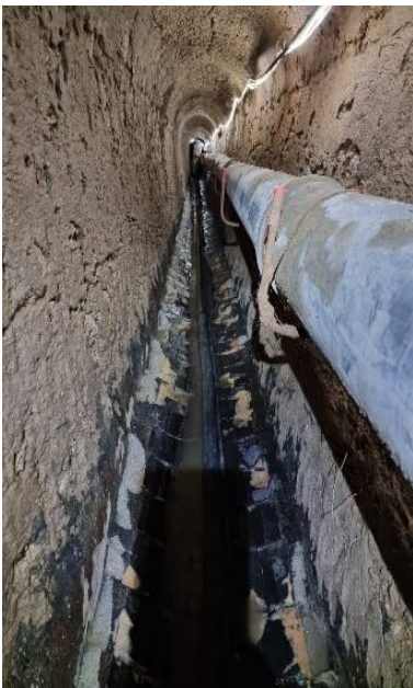
Avant travaux - ©CD94
