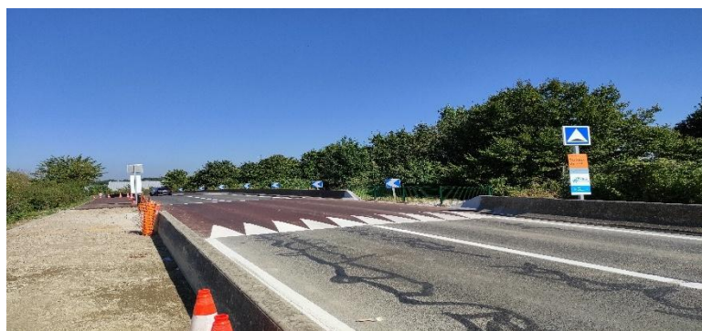
Plateaux surélevés à Santeny après travaux - ©CD94
