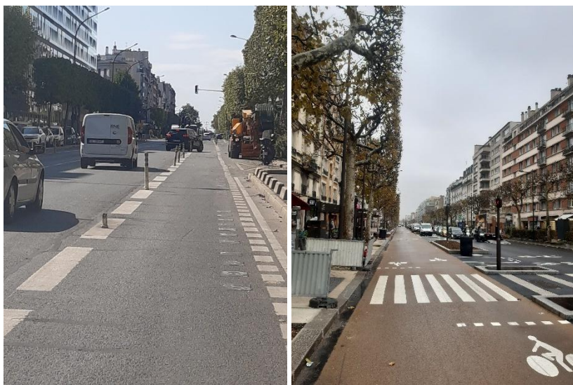
La RD120 avant travaux - ©CD94
