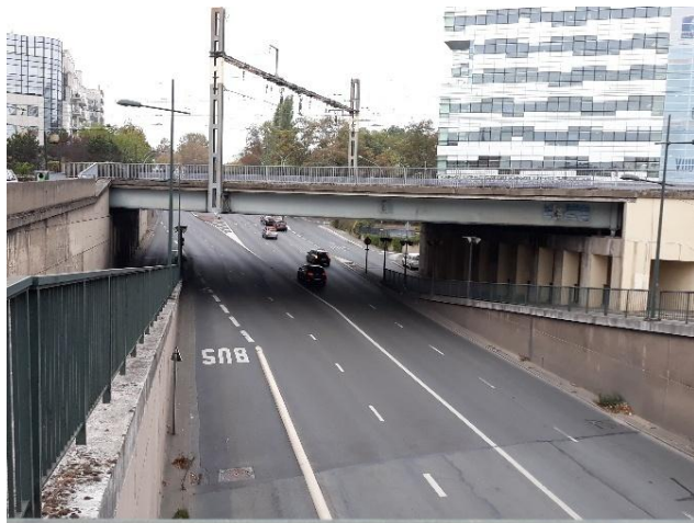
La RD4 avant travaux - ©CD94
