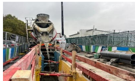
Travaux de reconstruction en urgence du réseau à Champigny-sur-Marne - ©CD94
