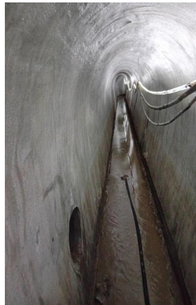
Après travaux - ©CD94
