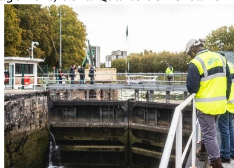
Activation de la vanne anti-crue du canal de Joinville-Saint-Maur dans le cadre de l'exercice HYDROS 2025 - ©CD94
