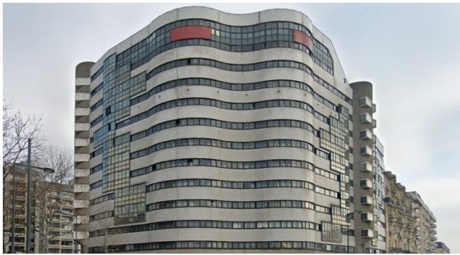
178 logements sociaux avant réhabilitation à Saint-Maurice - ©CD94
