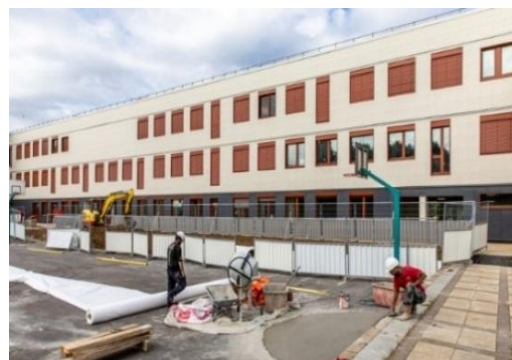
Chantier de réhabilitation du collège Paul Eluard à Bonneuil-sur-Marne - ©E.Legrand-CD94
