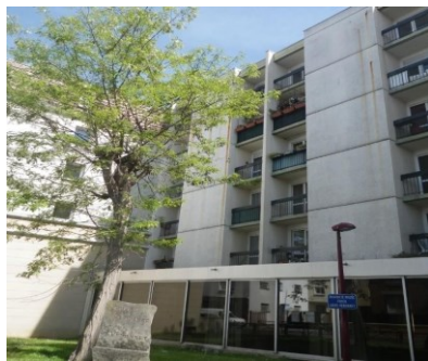
Bâtiment actuel source : LOGIREP
