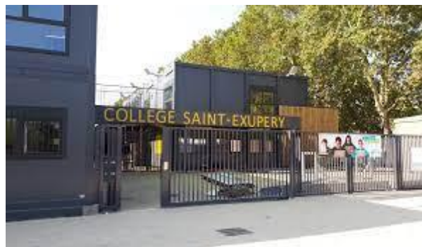
Aménagements du site Saint-Exupéry à Vincennes, financés à hauteur de 5 millions d'euros par le Fonds friches.
